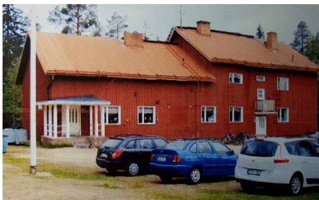
Mourujärven vuonna 1948 rakennettu kansakoulurakennus vuonna 2007 kuvattuna. Kuva: Sauli Jumisko, Jumiskon kotialbumi.
